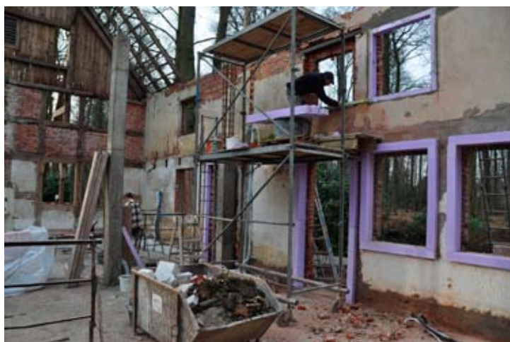
Befestigung der PU-Dämmschürzen um die Fensterleibungen
