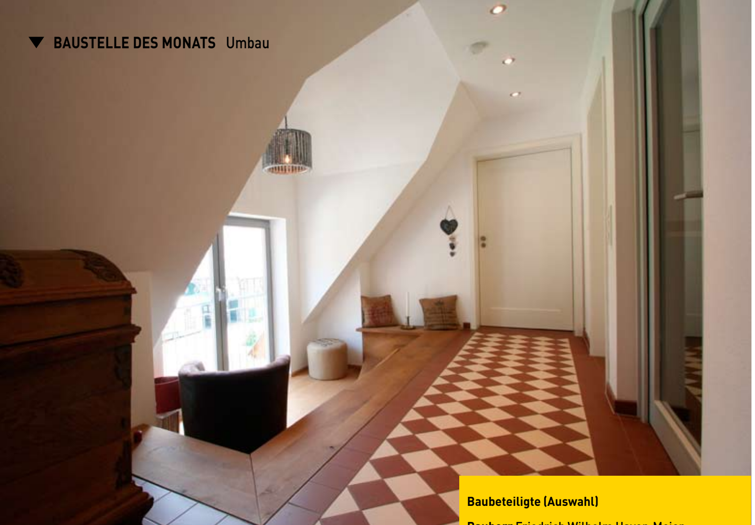
Die abgesenkte Sitznische hinter der Zwerggaube im Dachgeschoss der Remise Fotos (2): Thomas Wieckhorst
